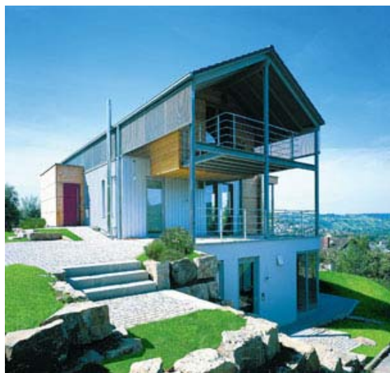
Figur 2: Enebolig med trebasert isolasjon. Foto: Homatherm
