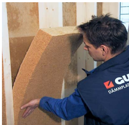
Figur 6: Montering av matter i stenderverk
